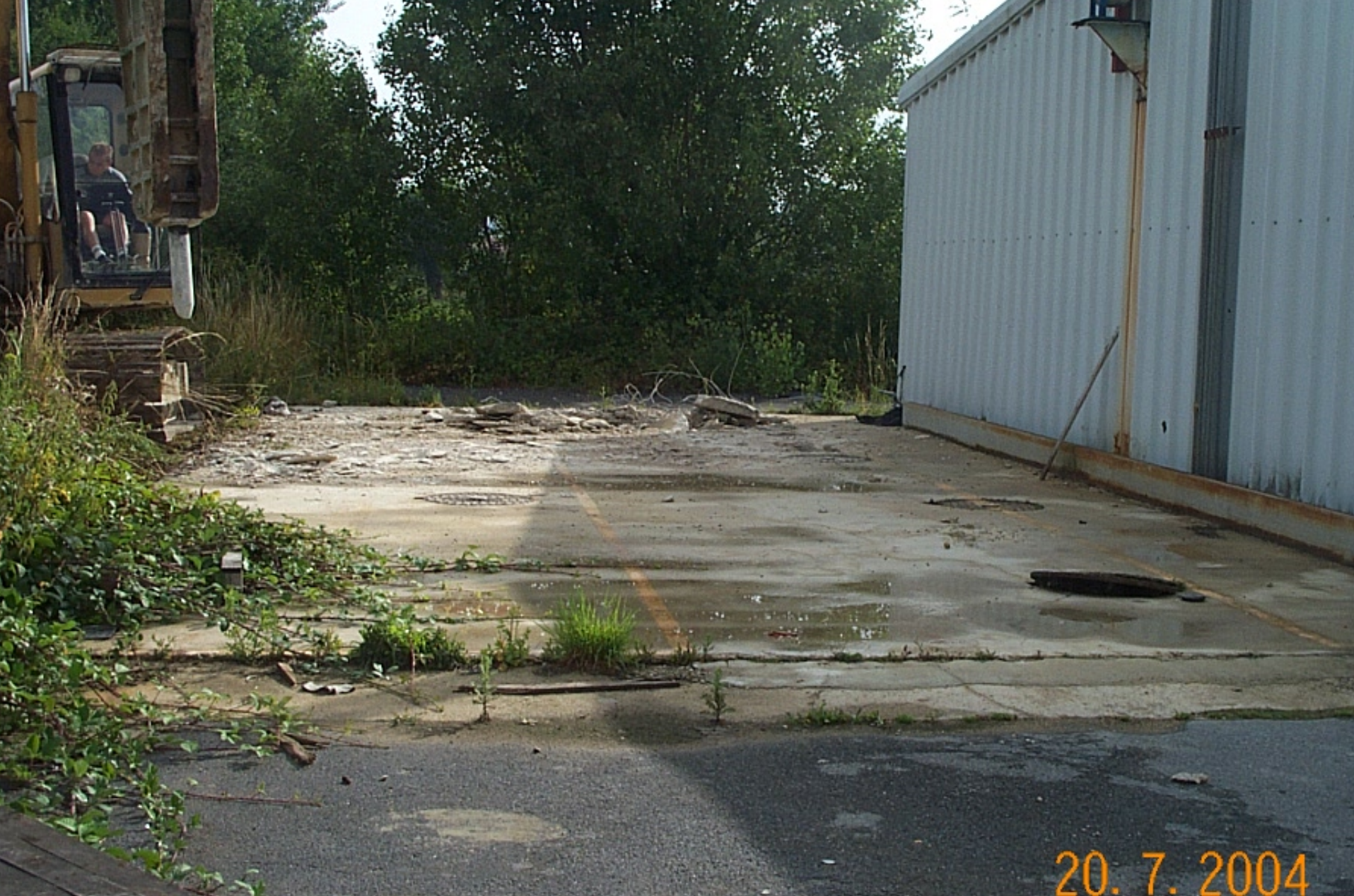
Vue de la zone de la fosse maçonnée avant démantèlement et dépollution
