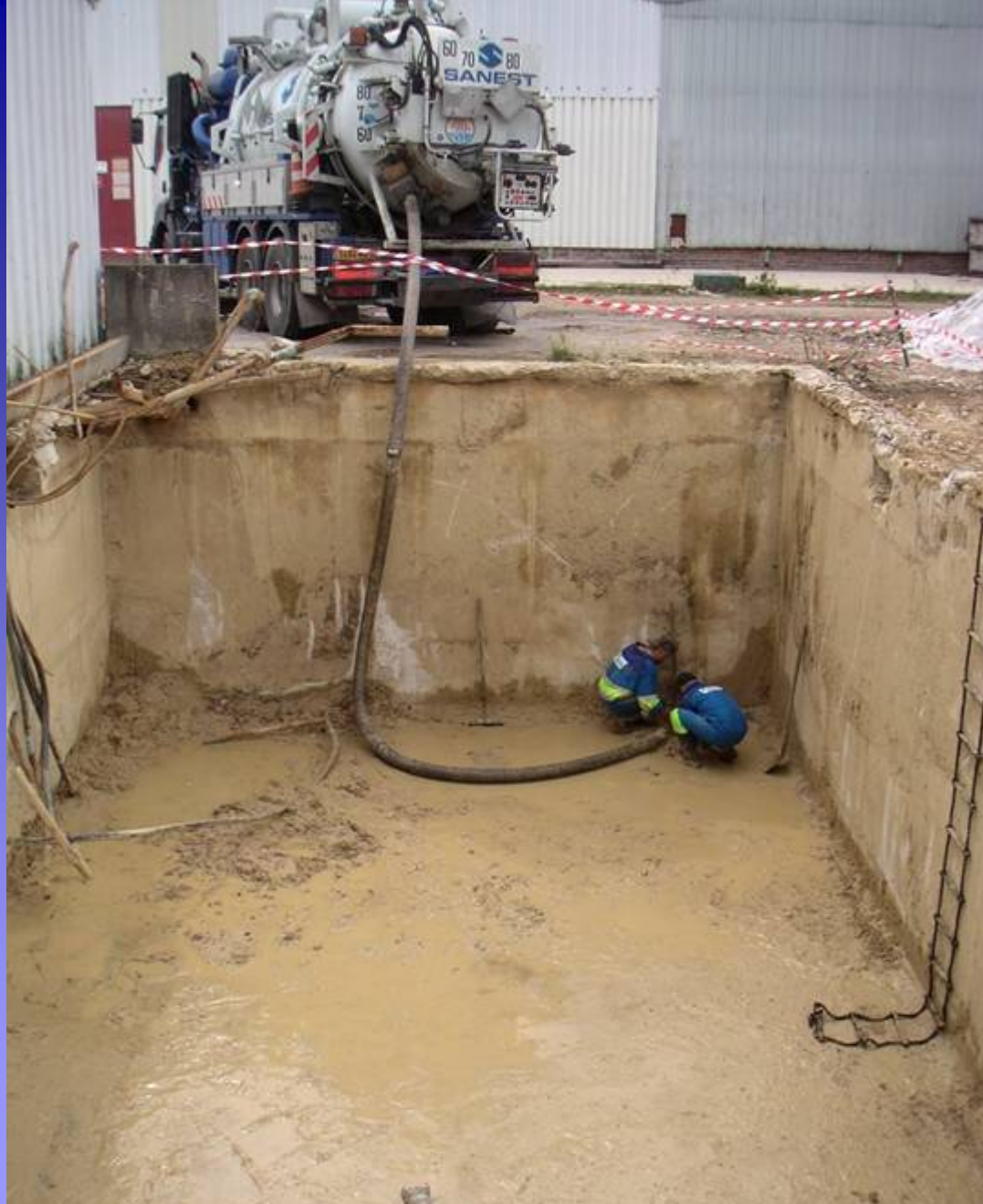
Phase terminale de nettoyage de la fosse maçonnée
