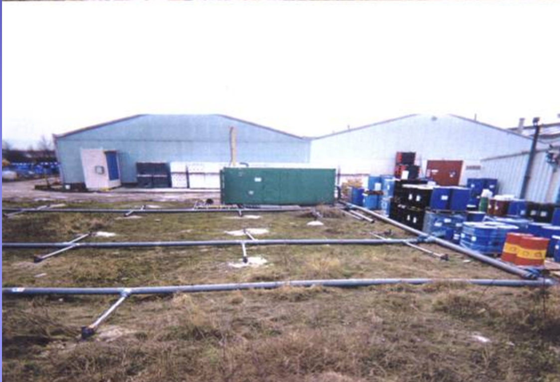
Traitement par venting de la pollution des sols en composés volatils
