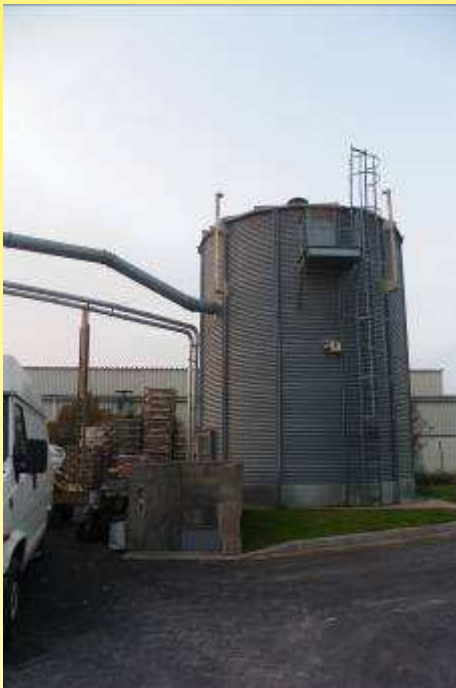
Silo stockage copeaux (7m hauteur)
