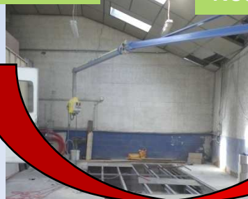
Travaux d'excavation pour la fosse
