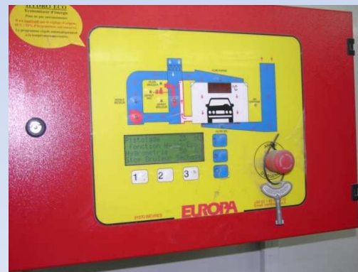
Pilotage automatique à l'extérieur de la cabine
